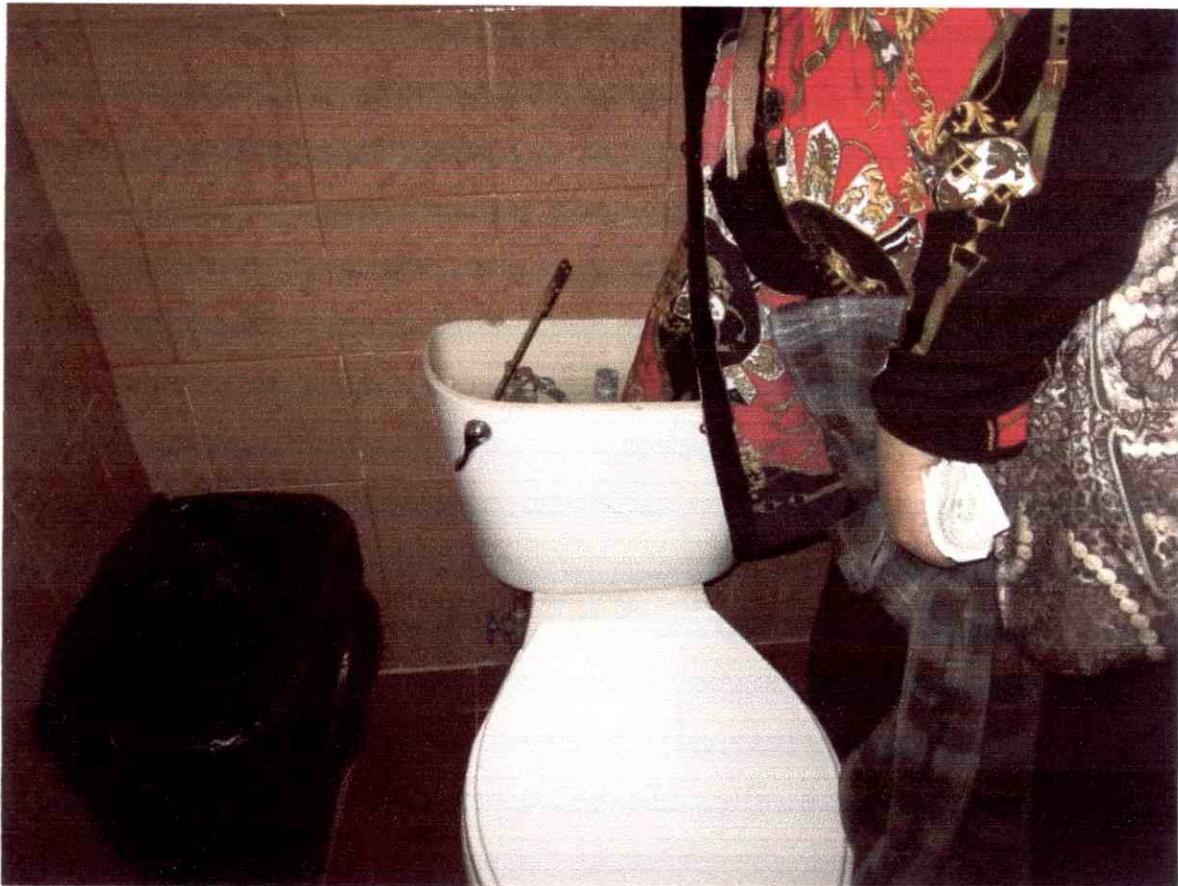
**ESTADO: EN ESTA TAZA NO LE SIRVE LA PALANCA PARA QUE BAJE EL AGUA A QUE METER LA MANO A LA CAJA PARA JALAR EL SAPO MANUALMENTE, DANDO MAL ASPECTO.**
