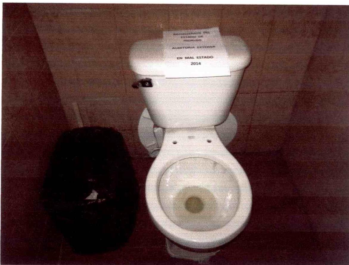
**ESTADO: LA TAZA DE BAÑO NO TIENE TAPA , ADEMÁS NO SIRVE LA PALANCA PARA QUE JALE EL SAPO SE TIENE QUE HACER MANUALMENTE.**
